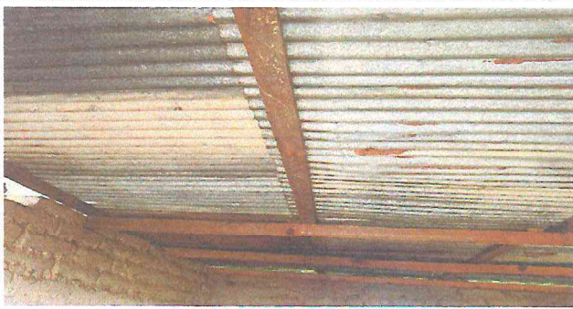
Foto 3: Sustrucción de techo de la cocina
