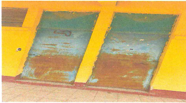
Foto 1: Sustrucción de puertas de las aulas
