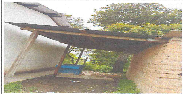
Foto 4: Paredes de la cocina
