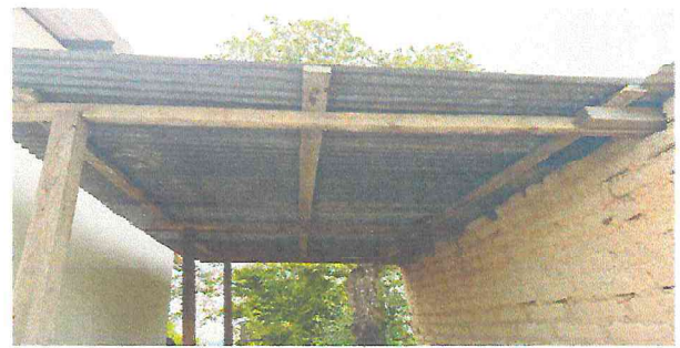
Foto 6: Sustrucción de techo del corredor de la cocina
