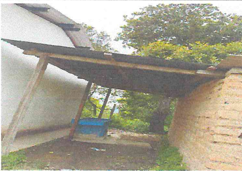
Foto 5: Sustrucción de techo del corredor de la cocina
