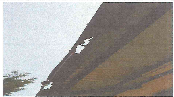
Foto 4: Sustrucción del techo
